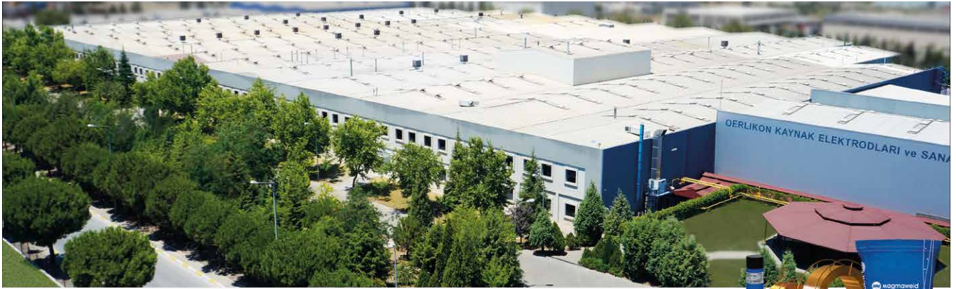
Welding Consumables Factory Organize Sanayi Bölgesi 2. Kısım, Manisa, Turkey
